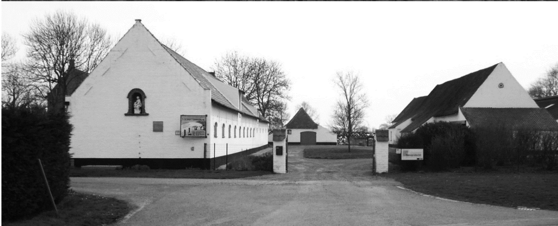
De nabijgelegen hoeve Het Schottenhof (2010)
