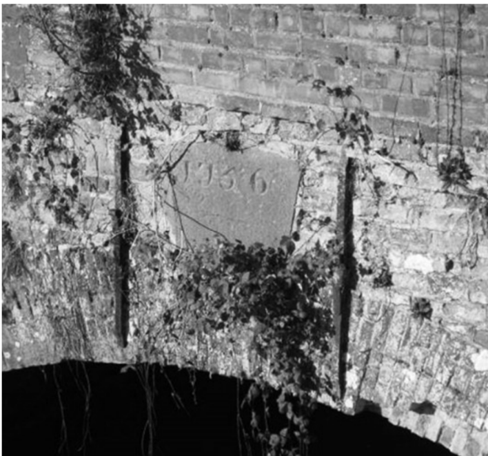
De steen met het jaartal 1756 is waarschijnlijk afkomstig uit de afgebroken stenen onderleider die in dat jaar gebouwd werd en hergebruikt in de brug over het Geleed uit 1860.
