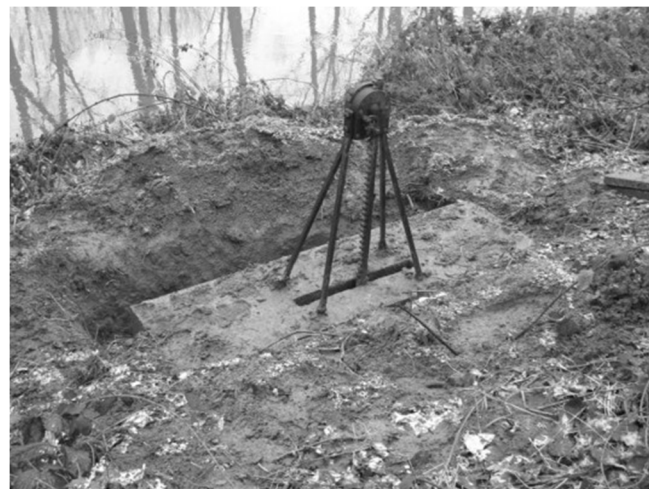
Via deze spindelschuif uit 1904 kon water uit het Schipdonkkanaal via de Lievebedding en een buizenstelsel de kasteelvijver van Moerkerke bijvullen.
