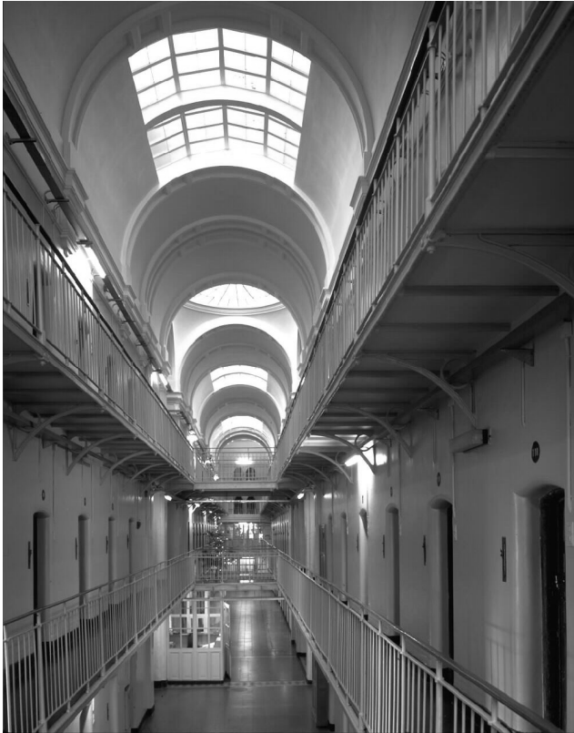
Binnenzicht van de vroegere gevangenis 't Pandreitje te Brugge in 1991 (foto VIOE)
