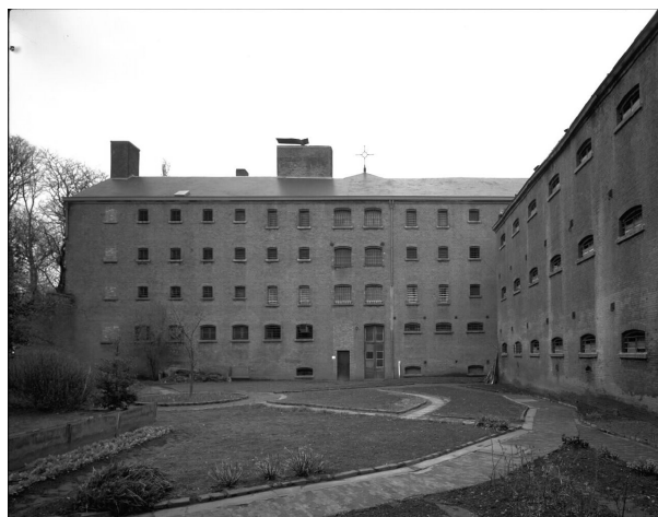
Buitenzicht van de vroegere gevangenis 't Pandreitje te Brugge in 1991 (foto VIOE)
