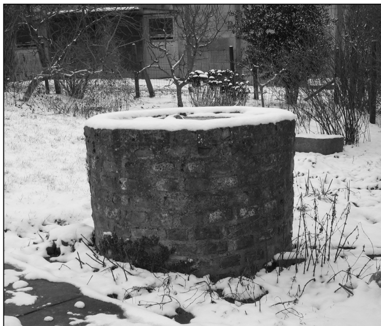
(Fig.2) De gemetste "keel" boven één van de twee met elkaar verbonden regenwaterputten. Baksteenformaat: 9,5 x 4,5 x 2,2 duim of 24,5 x 11,5 x 5,5 cm.
