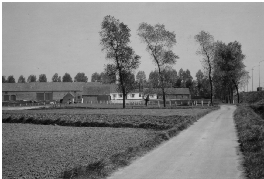
Foto van de hoeve kort na de omvorming van de drievaksbaan tot snelweg met 2 X 2 rijstroken.
