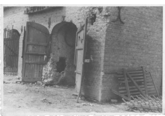
Obusgaten aan het einde van de grote bouw.
