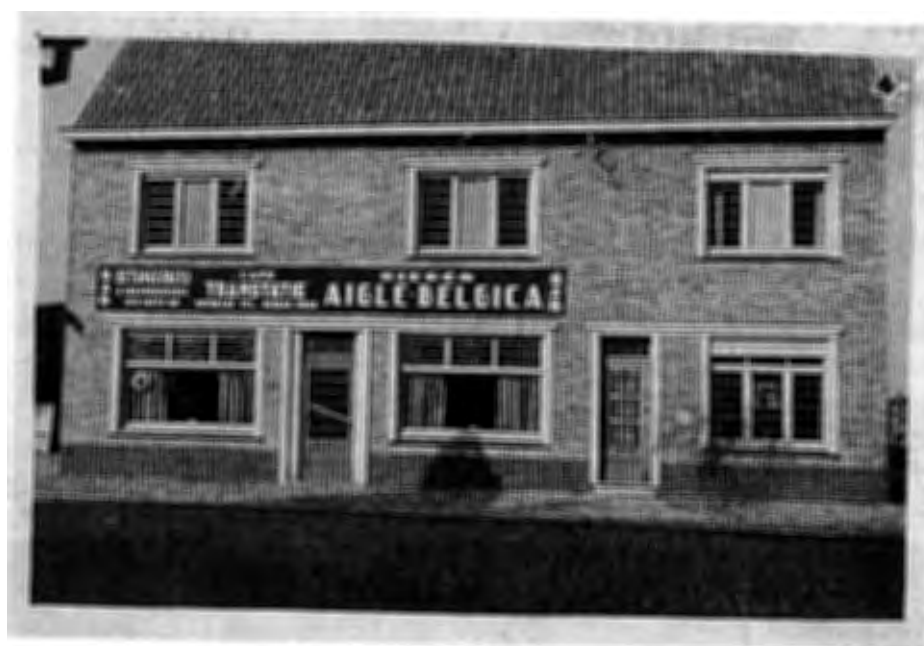
De gelijkvloerse en de opgetrokken, gemoderniseerde herberg "De Tramstatie"
