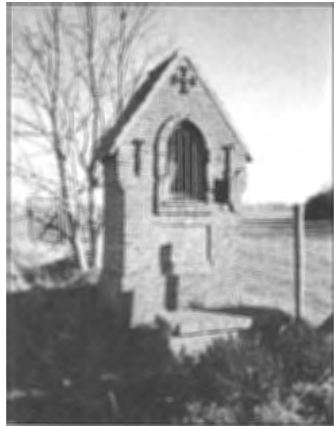
73. Strubbe's kapel, Westkapellesteenweg, Oostkerke
