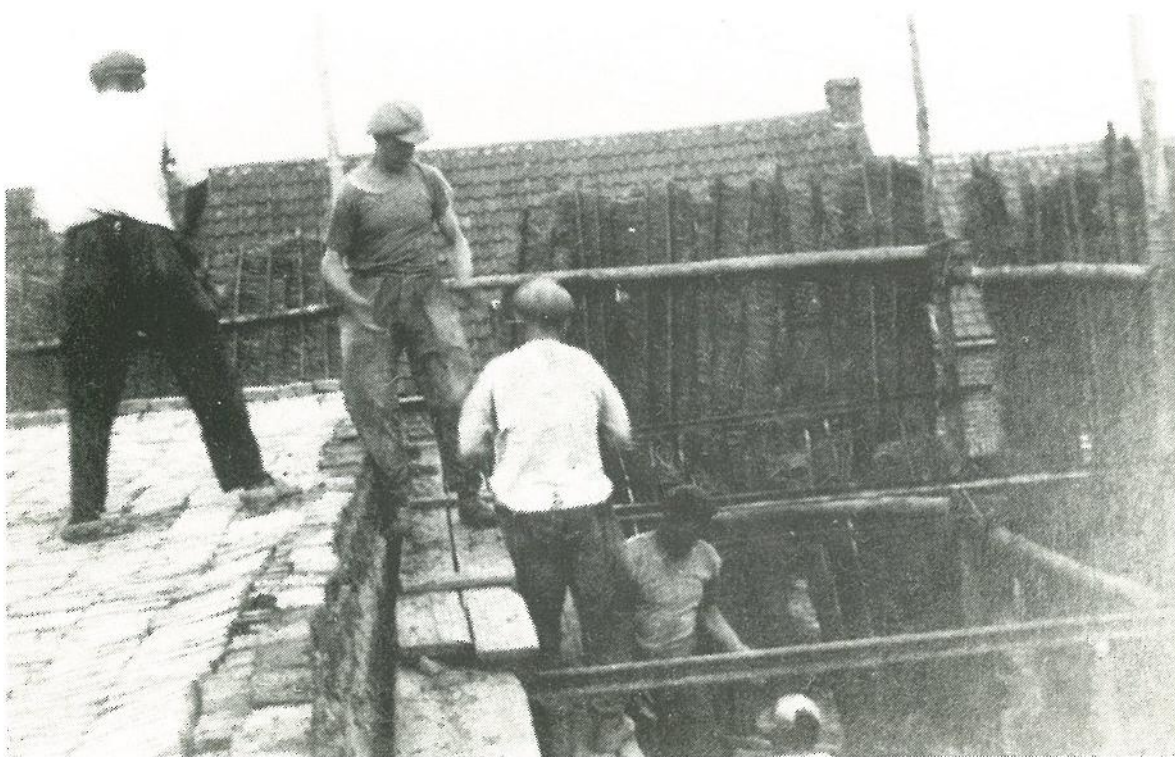
Gedroogde brikken worden opgestapeld om te branden. Rondom staan de 'gardevangs' (windschermen).
