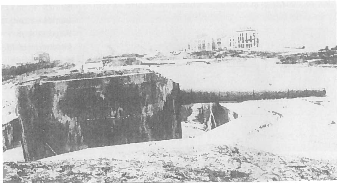
Freya – op deze prentkaart is duidelijk de achthoekige betonnen bedding voor het kanon zichtbaar.
