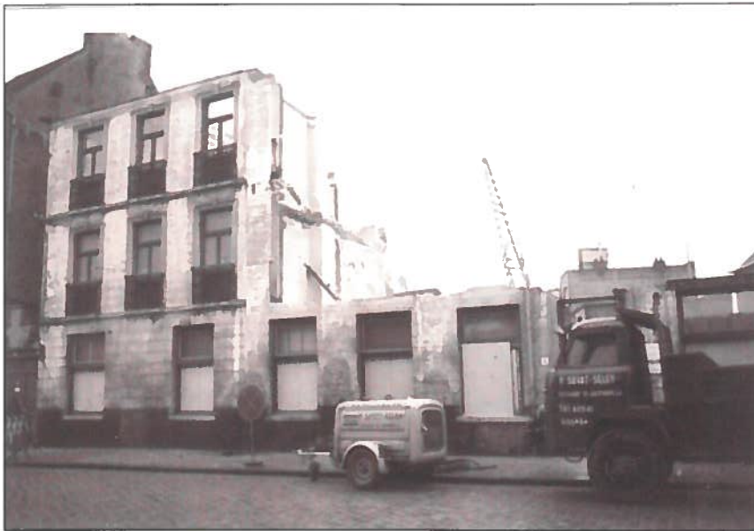
De sloopwerken in 1968.
