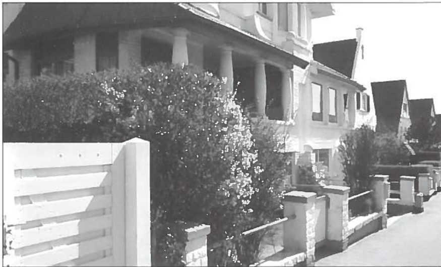
Figuur 11: Veranderingen : metalen omheining, veranda in de rechtervilla. Eigen foto, 15 april 2015.
