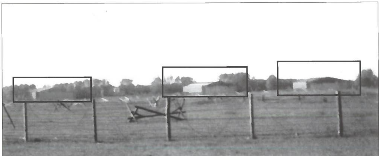
Vergroting detail van foto met 3 van de 7 vliegtuigloodsen tegen het koninklijk domein (parking bezoekerscentrum Zwin). Deze loodsen met afmetingen 26 m x 20 m, hadden drie muren opgetrokken in baksteen die bescherming boden tegen scherven van ontplofende bommen en een houten poort met verschuifbare delen. Het vliegveld is afgezet met prikkeldraad, Friese ruiters en andere obstakels.
