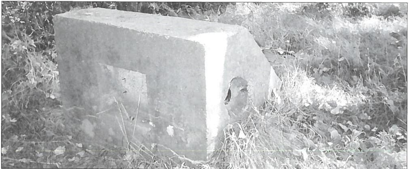
Deze 'Kabelbrunnen' bevindt zich bij het Leopoldkanaal te Ramskapelle.
