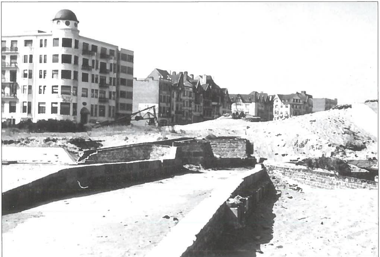
Een groot verschil met 1944: bunkers op het strand, gemetselde loopgraven en borstweringen, enz.
