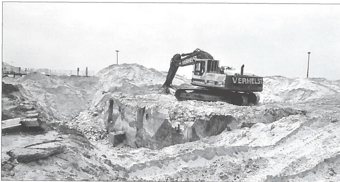
In oktober 2002 werd onder het Rubensplein een personeelsbunker Regelbau 502 blootgelegd en afgebroken, op de muren zit nog de originele camouflageverf. De bunker is een Doppel-gruppenunterstand voor 20 man en heeft 2 ingangen.
