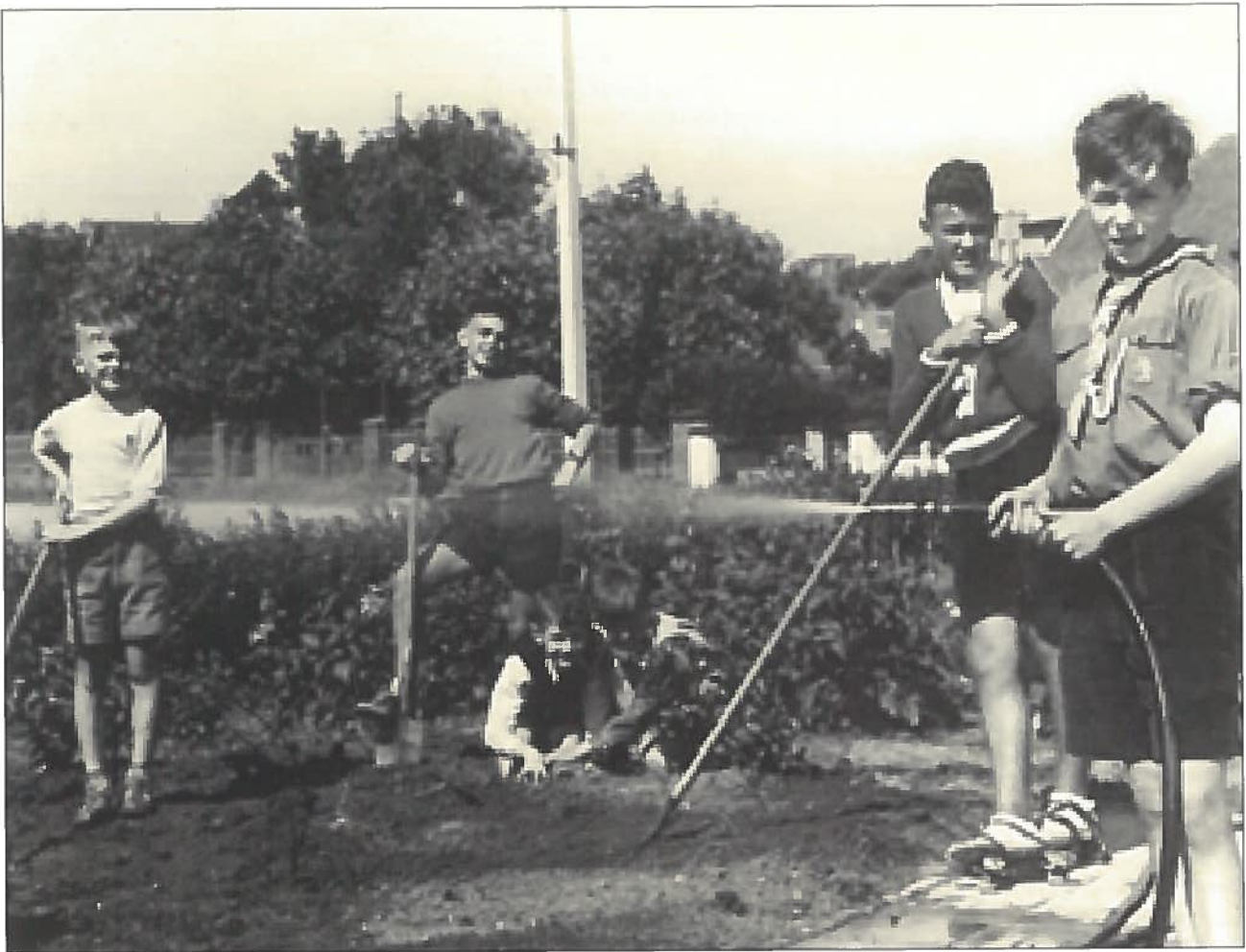
1952. Tuinaanleg door de leerlingen aan de grintweg. In de achtergrond ziet u een gedeelte van de Villa van de familie Debever. Raymond Vanhuysse met de tuinslang en Willy Reyms met voet op de schop.
