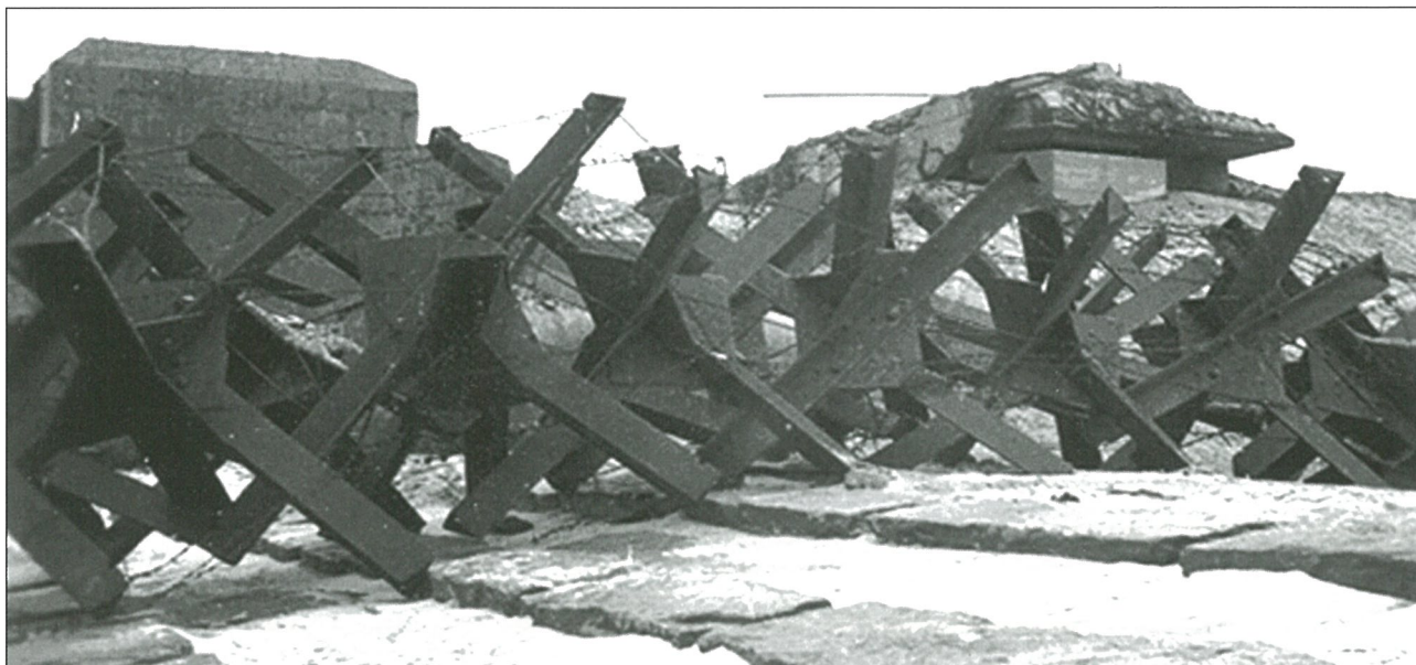
Tsjechische egels op een golfbreker te Knokke, zij werden ook op het strand opgesteld.
