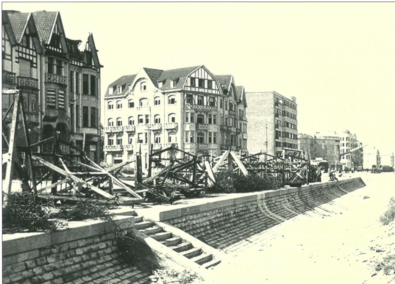
Elementen 'C' op de dijk van het Albertstrand te Knokke. De linkse staat met het achtereind naar het strand gericht.
