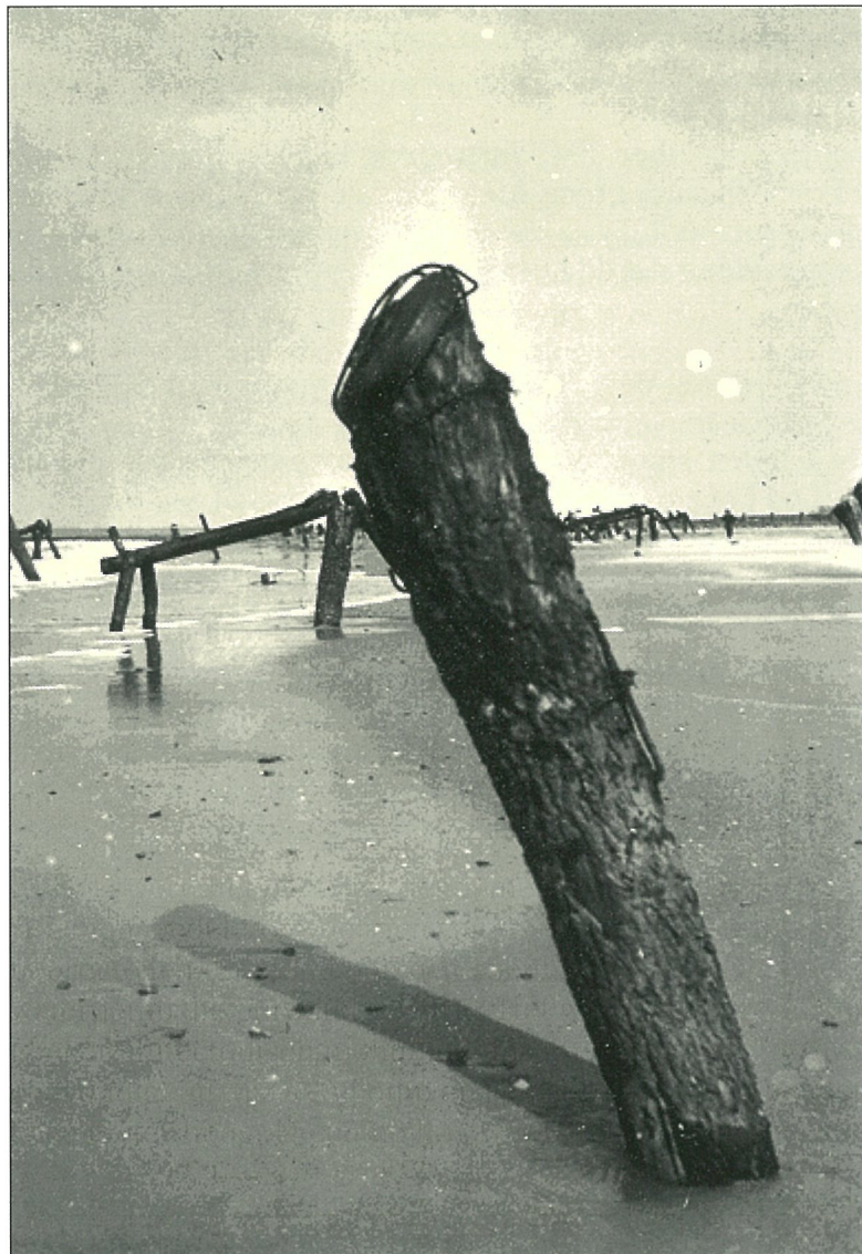
Knokke-Zoute. De antitankmijnen op de houten palen werden in een hoek van 45° zeewaarts gericht. Niet te verwarren met de 'Rommelasperges' die op velden meer landinwaarts werden geplant en onderling verbonden waren door kabels die springtuigen deden ontploffen, dit om het landen van zweefvliegtuigen en luchtlandingstroepen te verhinderen.
