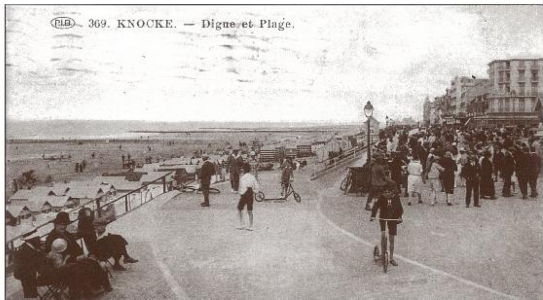
3. Lantaarnpaal (type 3) op de zeedijk ter hoogte van de Place Publique (Van Bunnensplein).
