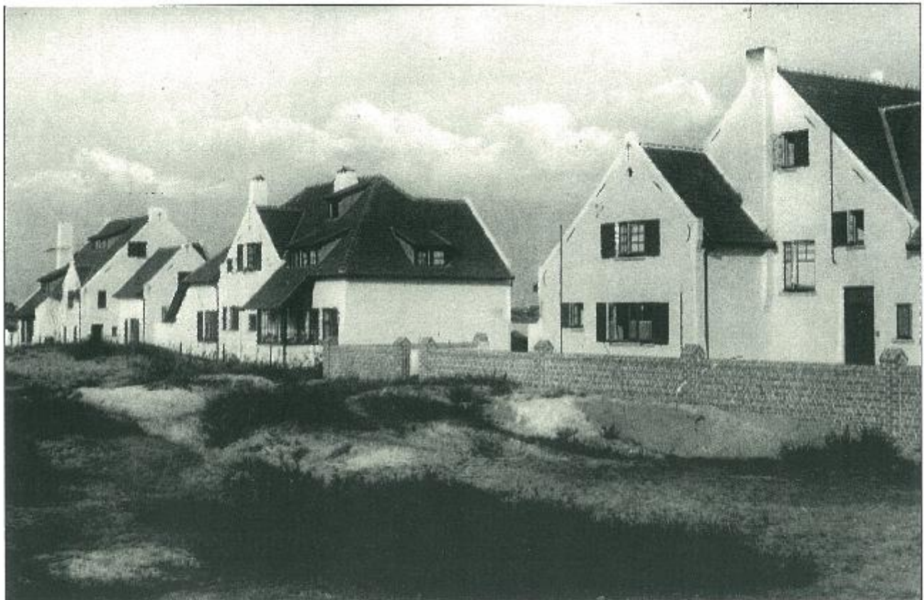
Adolphe Pirenne ontwierp de meeste villa's in het Vlaamspad. Rechts La Tyëbia met lage afschermmuur
