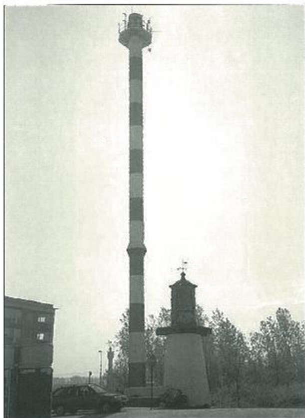
Het laag licht met de nieuwe constructie.
