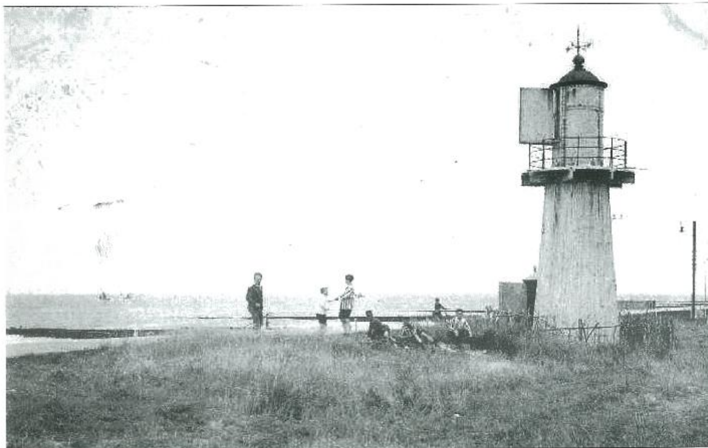
Het laag licht bij de Zeedijk.
