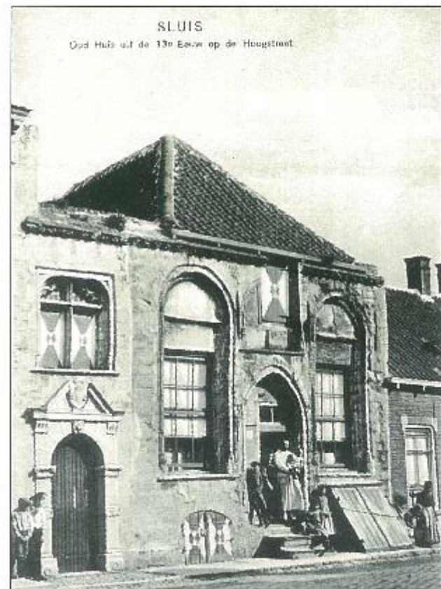
Het oudste bewaarde gebouw van Sluis was de vroegere Sint-Pieterskapel in de Hoogstraat. Het pand dateerde uit de 15e eeuw en had een centrale toegangsdeur en rondboognissen. Typisch was het "keldergal" met schuin deurvlak en trap. Door de hevige bombardementen werd het oude pand totaal vernield en niet meer heropgericht.
