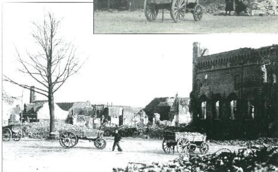
Restanten van het belfort
