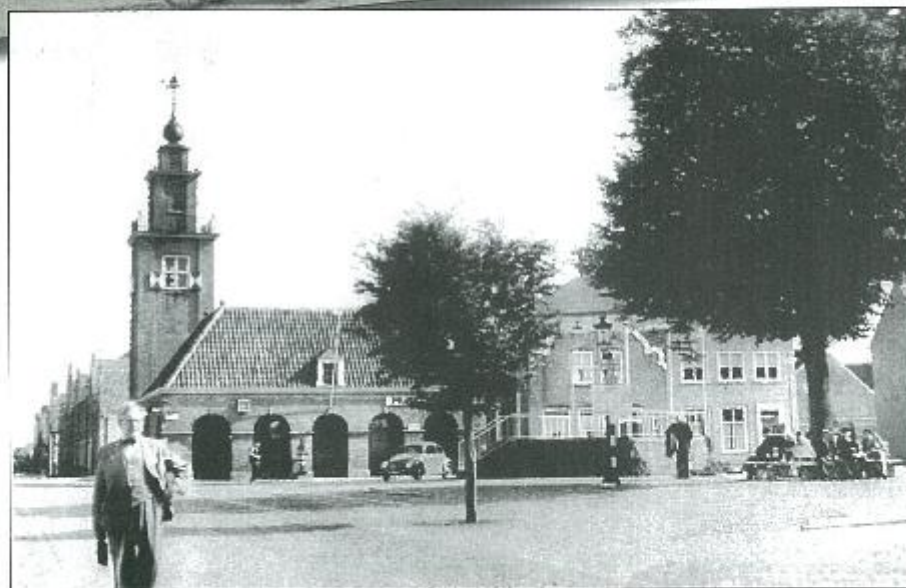
Het brandweeraarsenaal kreeg een toren en onder de arcaden werd in de jaren '50 een museum ingericht. De Wilhelminaboom heeft alles overleefd!
