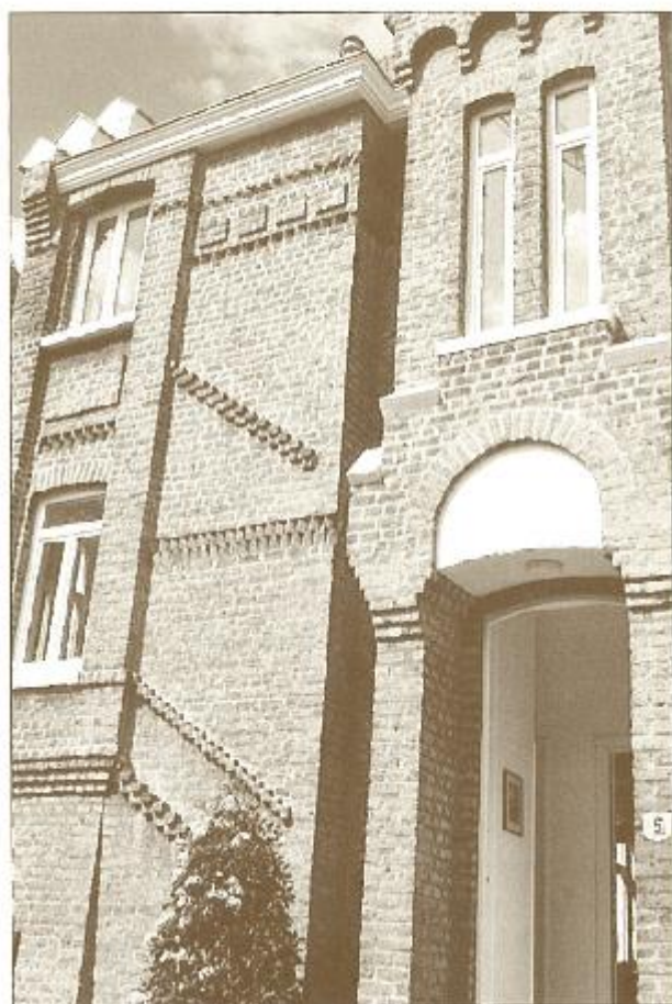
Detailopname van het keurig metselwerk in het linkse gedeelte van de voorgevel.
