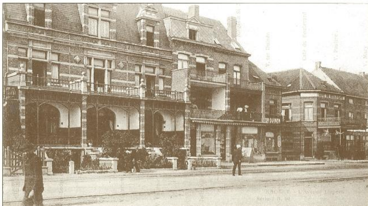
De villa's van de Lippenslaan, duidelijk herkenbaar aan de speklagen in het metselwerk, de brede raamopening en de arduinen buitentrap. De woningen kregen destijds de namen Lodge, Lucien en Eugénie toebedeeld. In de villa Lucien bevindt zich momenteel de handelszaak « Artistique ».
