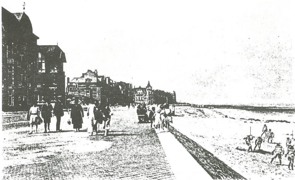
De Leopolddijk in 1922 met op de achtergrond het Grand Hotel du Zoute (hoek Albertplein)
